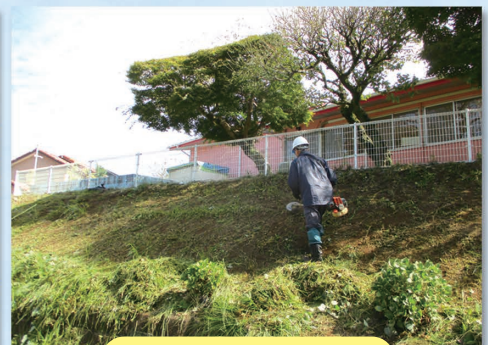
法面の草刈は安定した足場で
