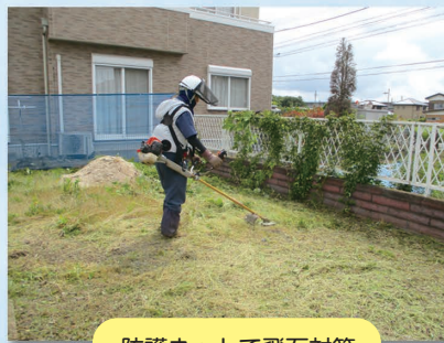
防護ネットで飛石対策
